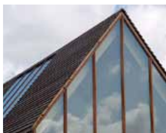
dakramen en pv-panelen verzinken in dakvlakken
